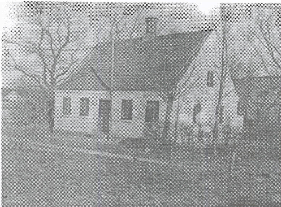
Telefoncentralen i Nøvling ca. 1920. På skiltet t.v. for døren står: SAMTALESTATION.
